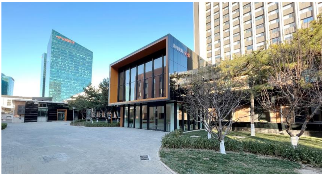
图 1 中国建研院光电建筑外观
